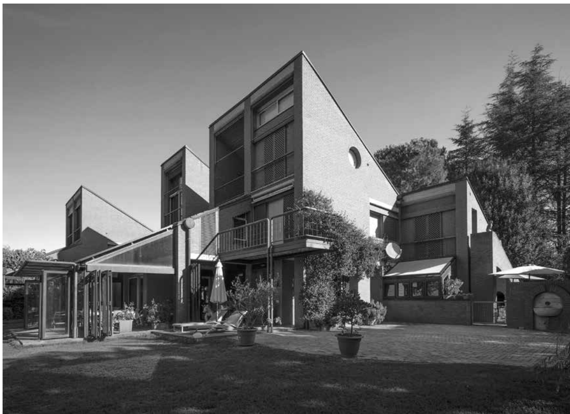
Edifici residenziali - Tetti Acquaviva, strada Roaschia 141, Chieri, 1985, M. Vitali (collaborazione E. Senatore)
