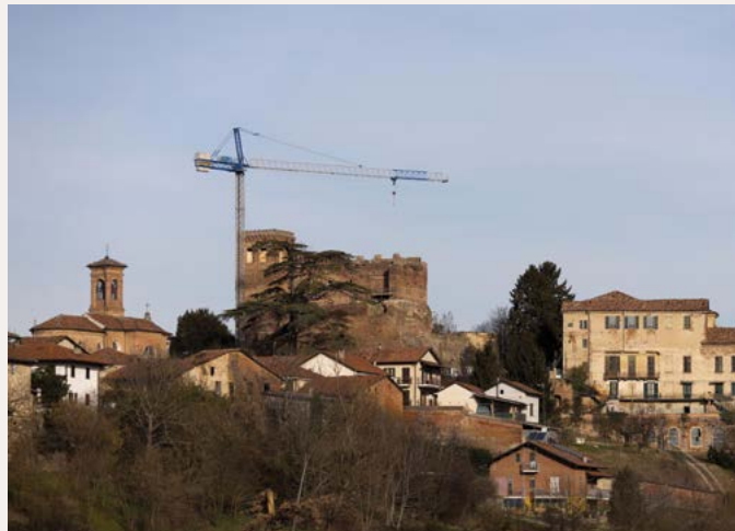
La Rocca in fase di ristrutturazione. A destra Villa Bianca (foto archivio picchioverde).
