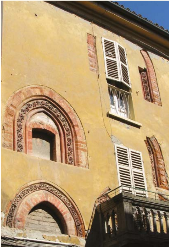
Fig. 2 Chieri, palinsesto della casa di via S. Giorgio 6 con decorazioni carpologiche.
